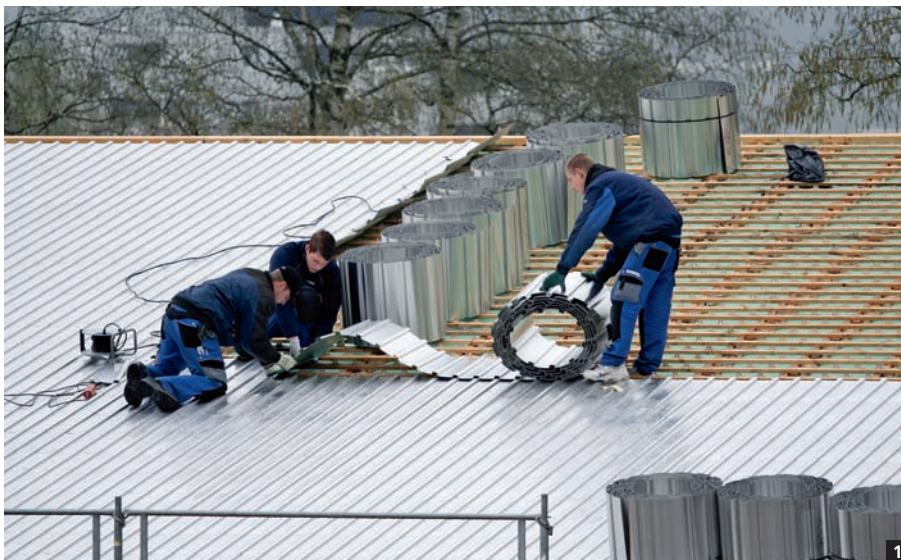
Die Aluminium-Furalbänder lassen sich einfach und schnell verlegen.
